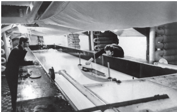
Рис. 1. Первый в мире опытовый ледовый бассейн, открытый в ААНИИ в 1955 г. Fig. 1. The world’s first ice tank, opened at the AARI in 1955
