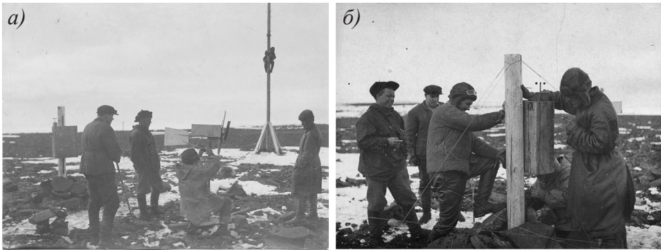
Рис. 4. Работы по установке АМС на плато близ полярной станции Бухта Тихая. 12 июня 1934 г.: а) установка блока метеоприборов АМС; б) монтаж радиопередатчика АМС. Фото М.А. Чистова. Фонды ААНИИ
