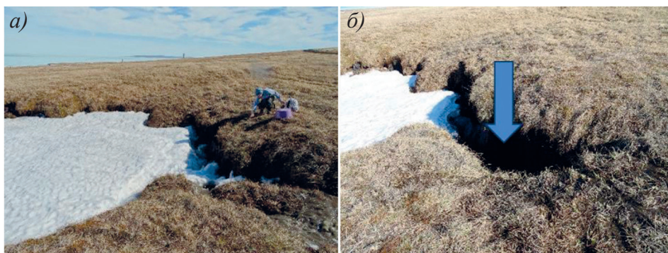
Рис. 6. Обрушение блока отложений в вершине оврага (вертикальная стрелка): а — 04.06.2022; б — 08.06.2022
