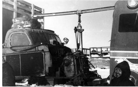
Ремонт коробки передач на АТТ 15
