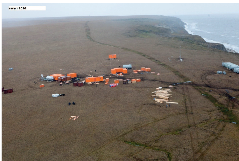
Рис. 11. Вездеходная дорога, проложенная до основания станции, по которой происходит активное протаивание грунта
