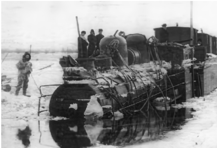
Рис. 3. Авария на ледовой переправе через р. Амур.
