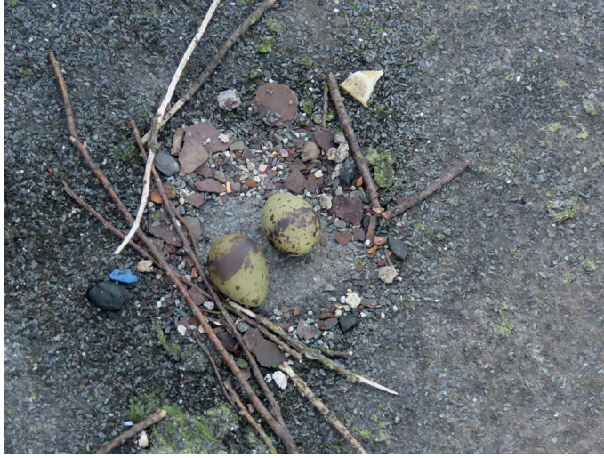
Рис. 4. Гнездо полярной крачки на крыше здания вертолетного отряда, 06.07.2025
